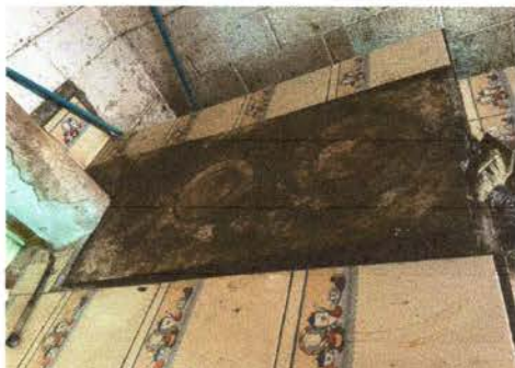
Foto 1: Plancha para preparación de alimentos en mal estado
